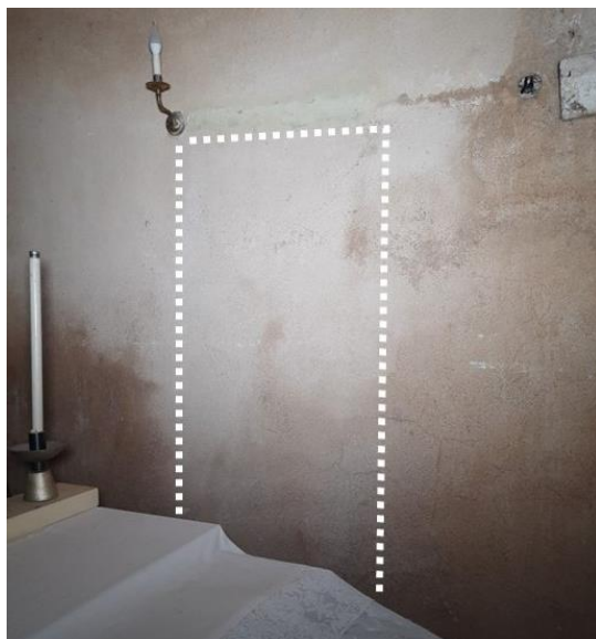
Figura 28 - Apertura sul vano di sinistra oggi, lato vano di sinistra
