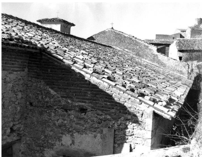
Figura 30 - Vano di sinistra, finestra: anni Sessanta
