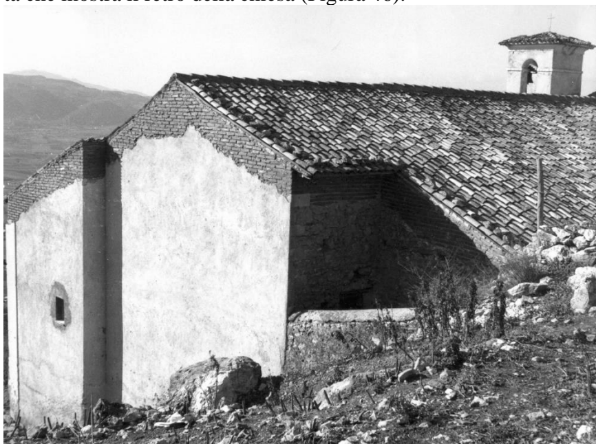
Figura 46 - Rifacimento in mattoni, anni Sessanta
