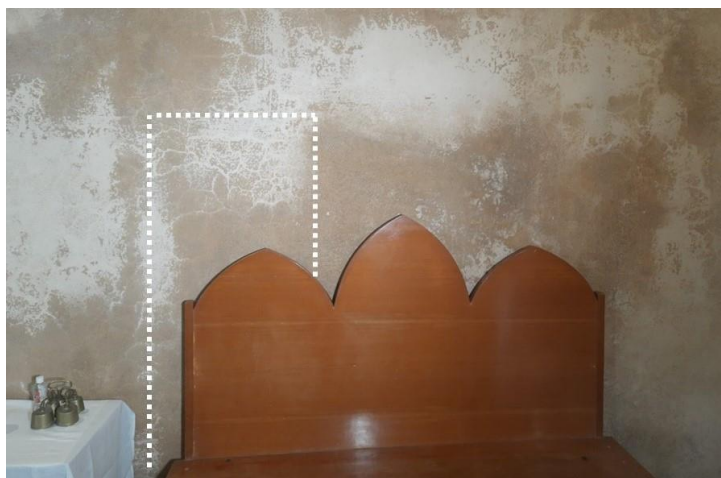
Figura 27 - Apertura sul vano di sinistra oggi, lato abside
