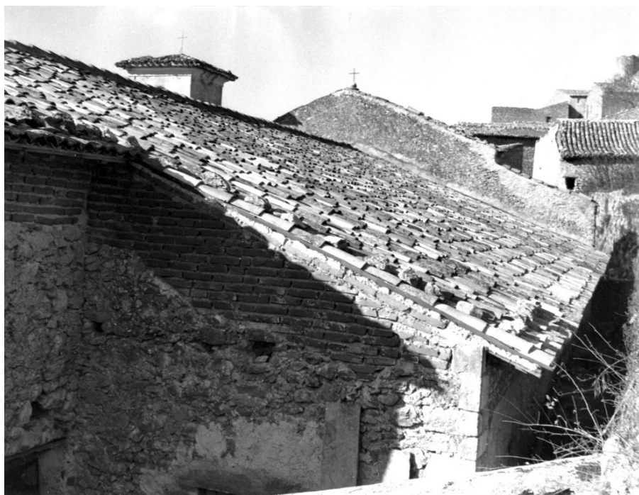
Nella foto sopra e sotto è mostrato il retro della chiesa. Da notare lo strato di mattoni presente nella parte superiore delle mura.
